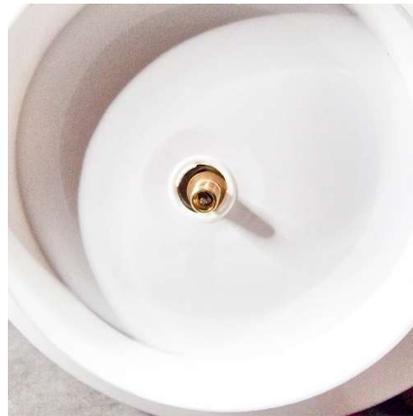
Realizada esta comprobación, instalaremos la llave del depósito, es importante verificar previamente que en la parte superior del depósito en la base de la rosca, está la junta blanca de cierre correctamente instalada para evitar fugas.
